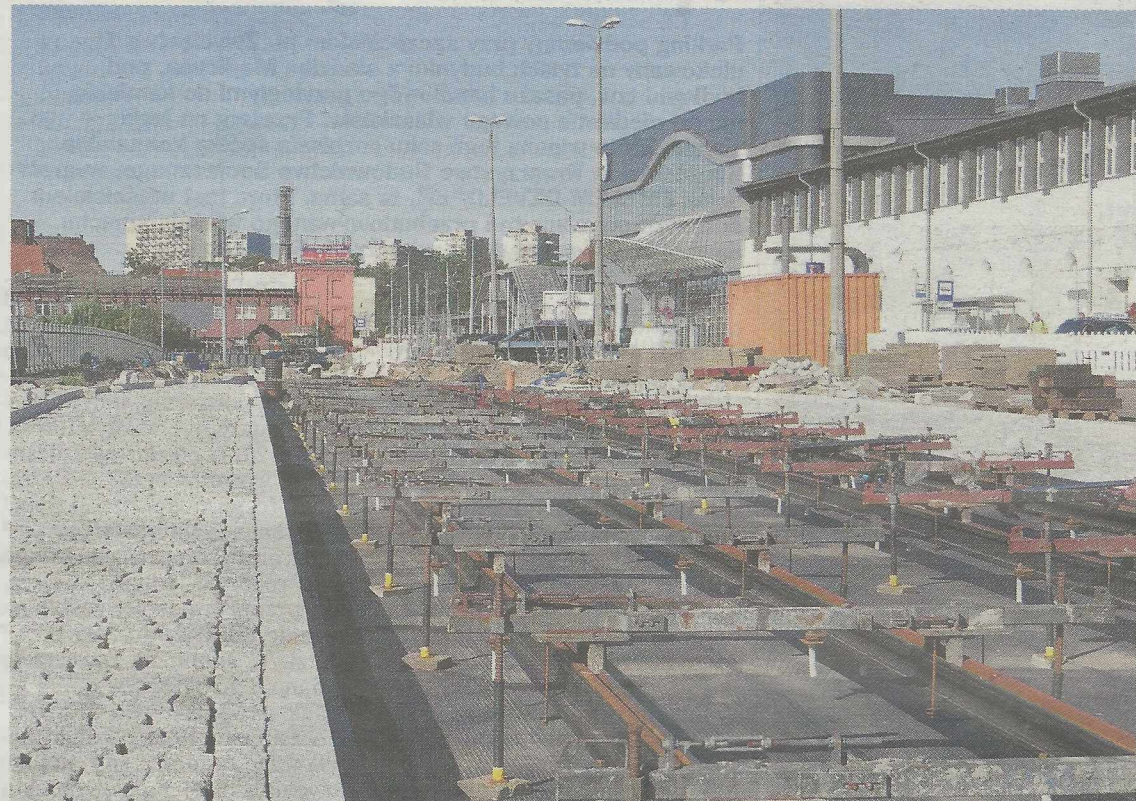
Ul. Krzysztofa Kolumba w trakcie przebudowy
