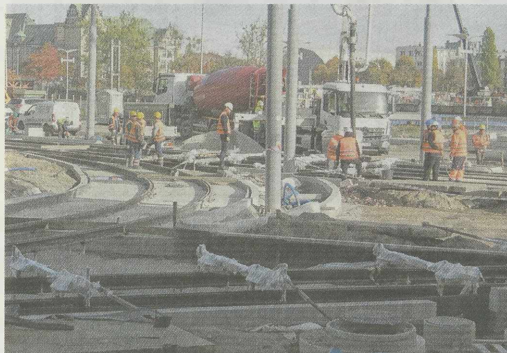
Ulice Nabrzeże Wieleckie i Dworcowa – postęp prac przy przebudowie.
