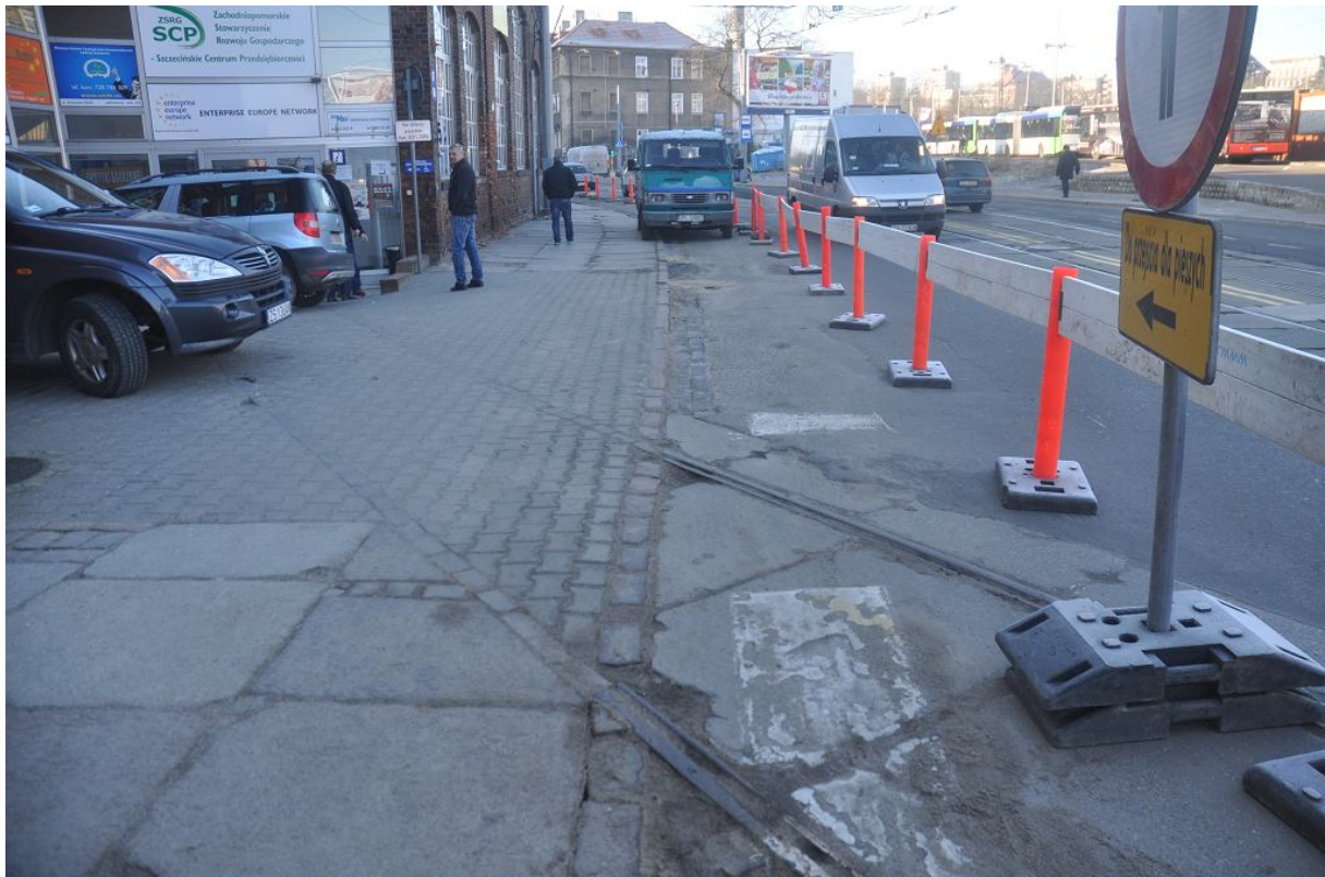
Ulica Kolumba. Tor prowadzący do dawnej zajezdni, a potem warsztatów tramwajowych Fot. Andrzej Kraśnicki jr
