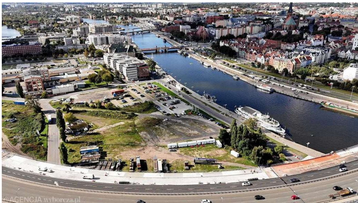
Łasztownia na południe od Trasy Zamkowej, gdzie będzie zjazd z Mostu Kłódnego Fot. Cezary Aszkiełowicz / Agencja Wyborcza.pl
