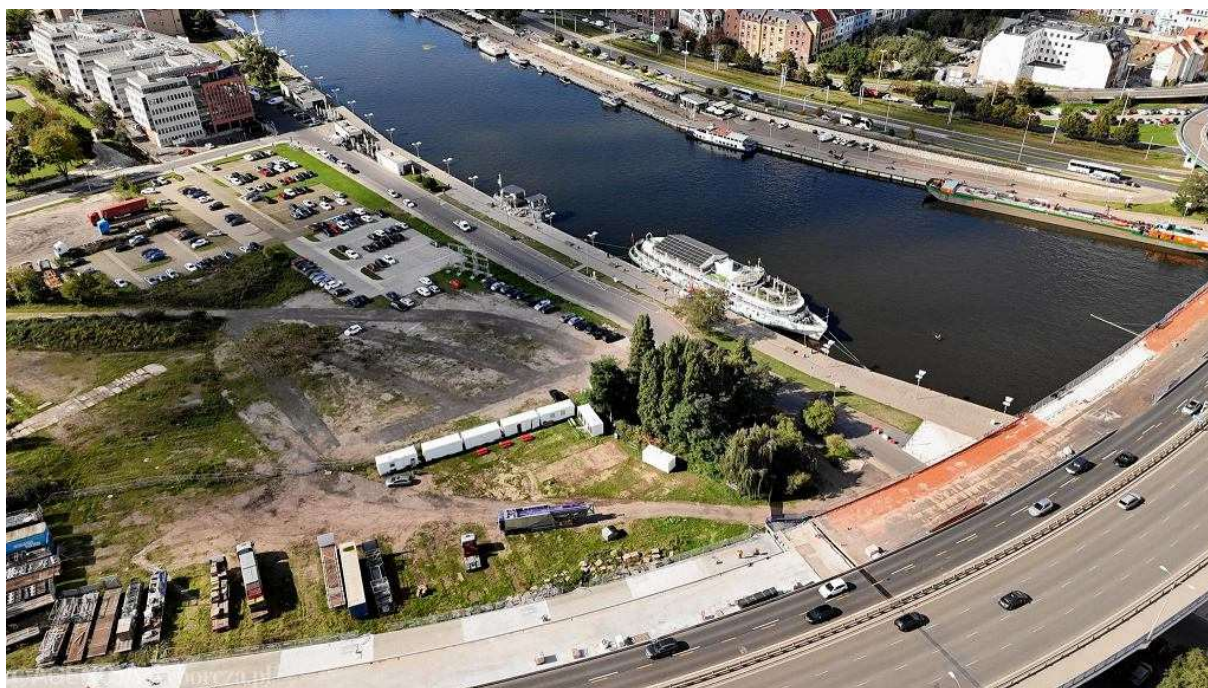
Rejon zjazdu z mostu Kłodnego na Łasztownię Fot. Cezary Aszkiełowicz / Agencja Wyborcza.pl
