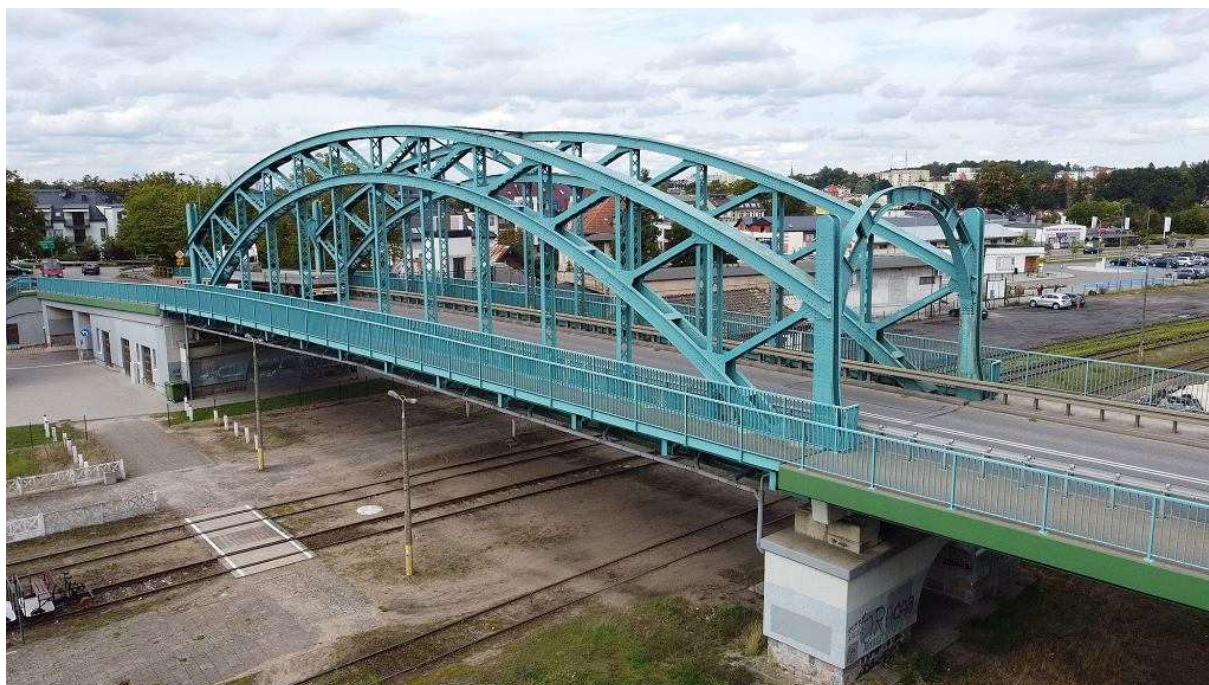
Przęsło mostu Kłodnego nad torami kolejowymi w Bytowie fot. Andrzej Kraśnicki jr
