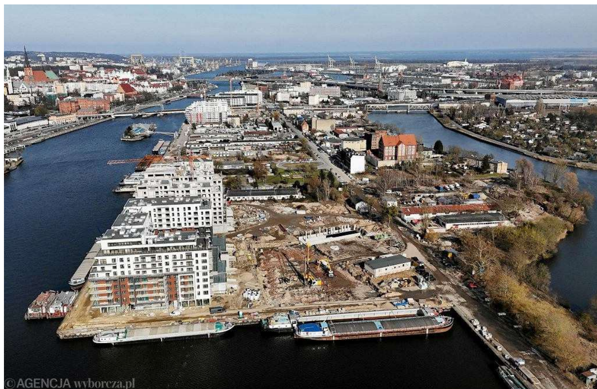
Międzyodrze. Widok na Kępę Parnicką w Szczecinie od strony południowej z widoczną budową pierwszego etapu osiedla Sedina Apartamenty. Inwestor - Budnex, projekt - Federacyjne Biuro Architektów w Szczecinie Fot. Cezary Aszkiełowicz / Agencja Wyborcza.pl
