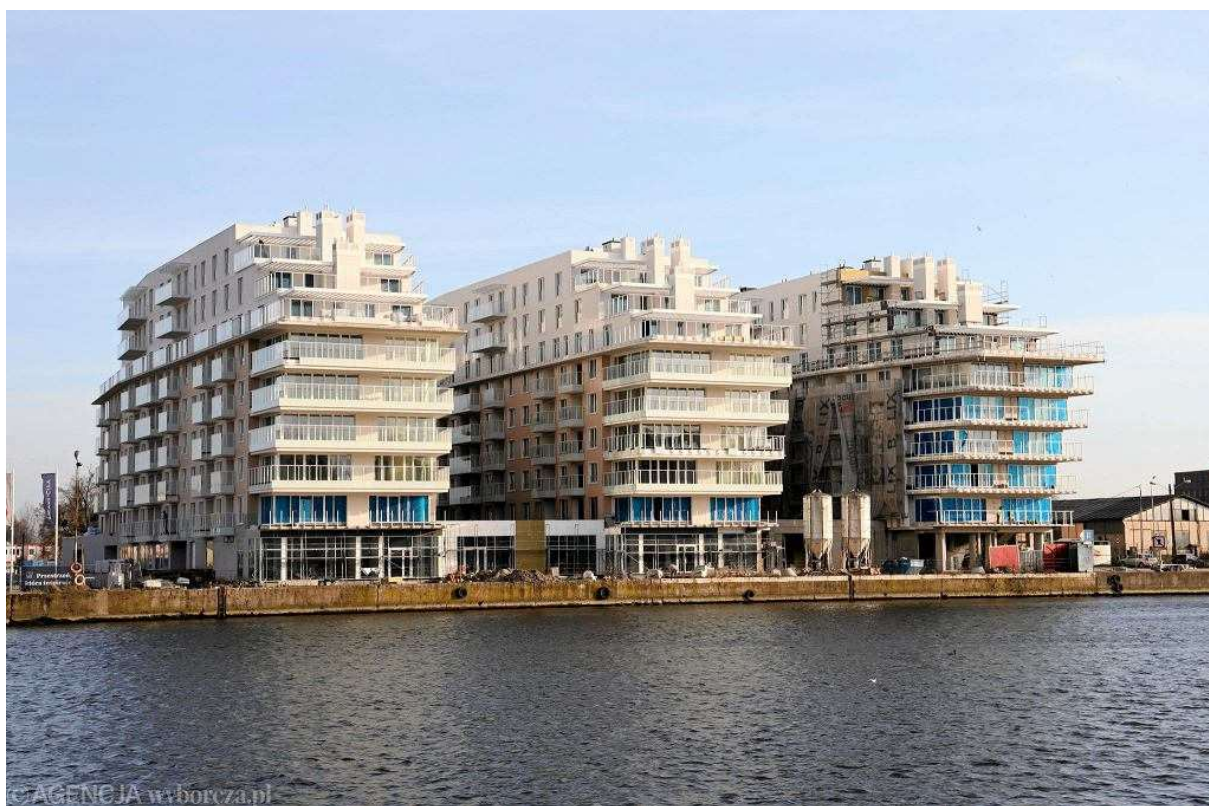
Budowa osiedla Nowa Przystań na Kępie Parnickiej naprzeciwko dworca Szczecin Główny. Inwestor - Siemaszko, projekt - Federacyjne Biuro Architektów w Szczecinie Fot. Cezary Aszkiełowicz / Agencja Wyborcza.pl
