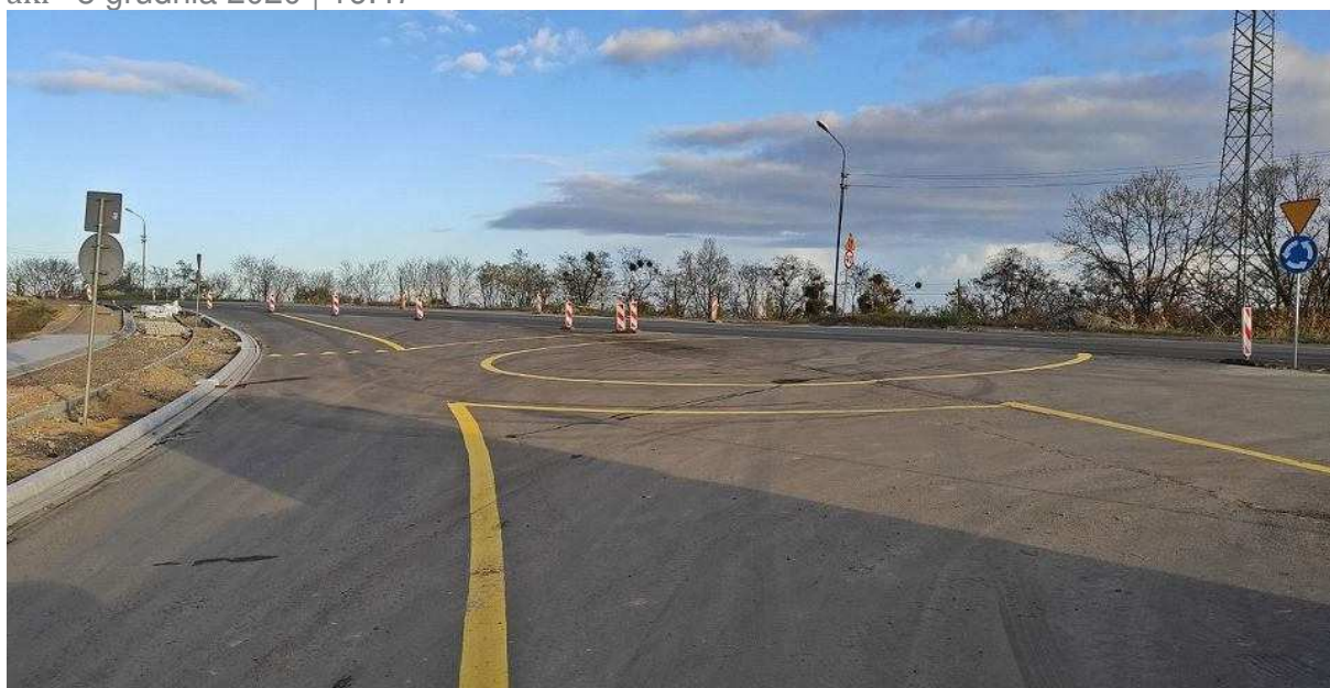
Budowa węzła Granitowa. Grudzień 2020 (Urząd Miasta)
