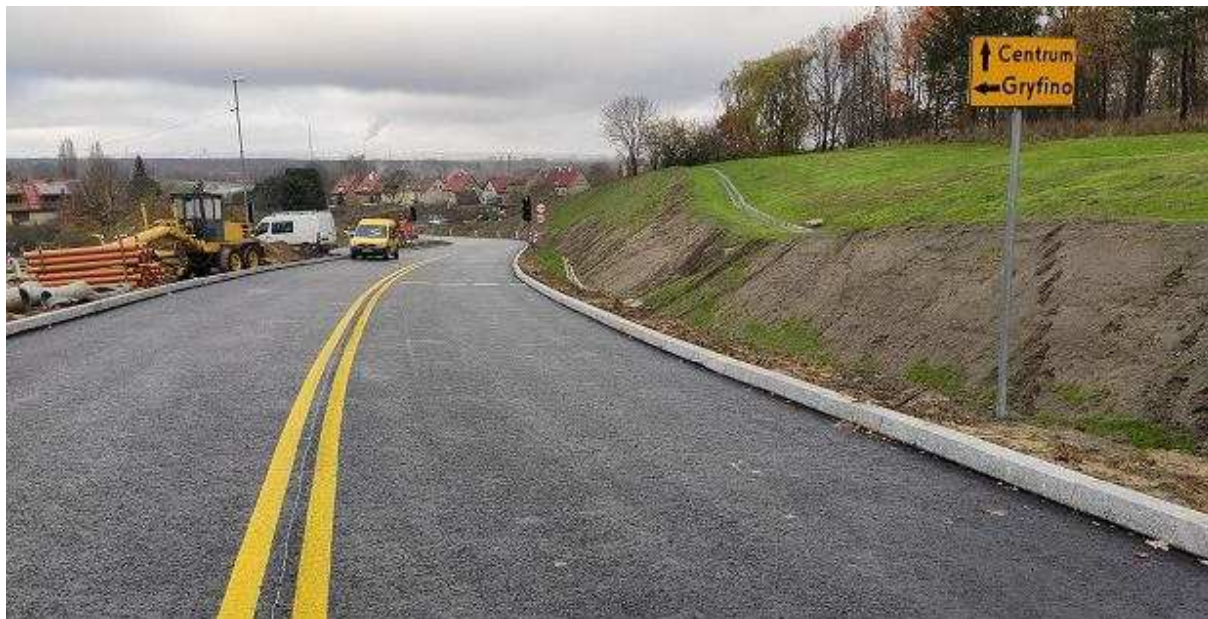
Budowa węzła Granitowa. Grudzień 2020 Urząd Miasta
