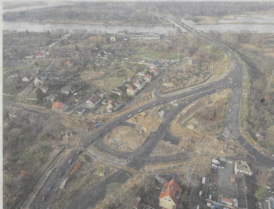
Na zdjęciu przebudowa węzła w Podjuchach – z lotu ptaka
