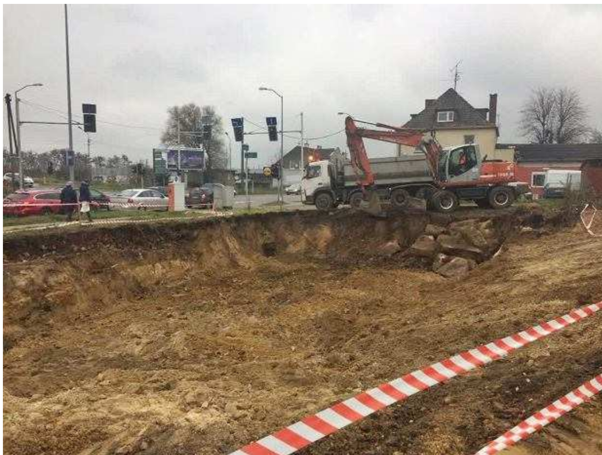
Budowa węzła Granitowa Urząd Miasta
