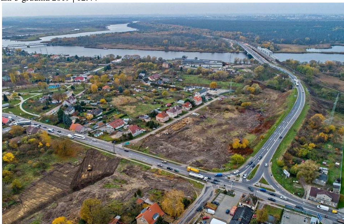
Budowa węzła Granitowa (Urząd Miasta)
