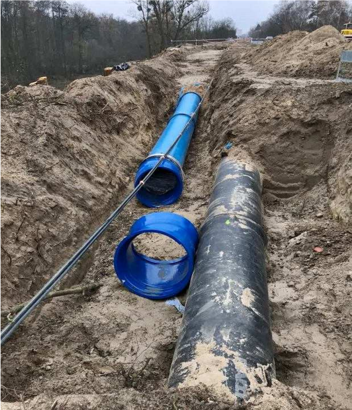
Budowa węzła Granitowa Urząd Miasta
