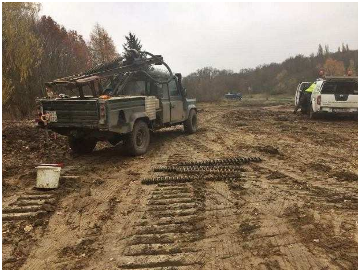
Budowa węzła Granitowa Urząd Miasta
