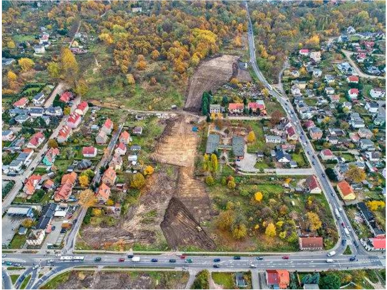
Budowa węzła Granitowa Urząd Miasta
