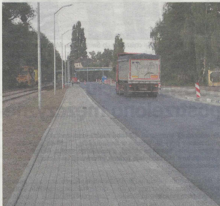
W ramach prac przebudowana została nawierzchnia jezdni na długości 1 km.
