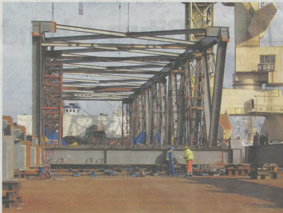
Pierwsze przęsło mostu Brdowskiego
