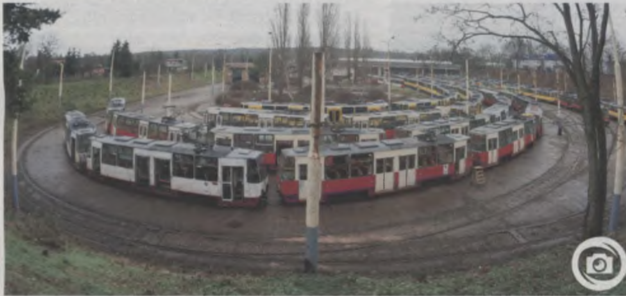
Zajezdnia Pogodno, w której stacjonuje większość szczecińskich tramwajów, wkrótce zostanie gruntownie zmodernizowana.
