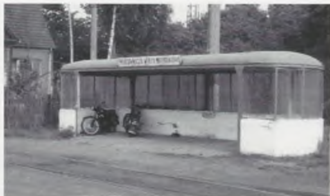
Czy powstała na terenie zajezdni Pogodno Pracownicza Wiata Motocyklowa została budowana w oparciu o pudło wagonu 528? Wszak kształt linii dachu ludzko przypomina dach wagonu z Bergen. Ze zb. autora
