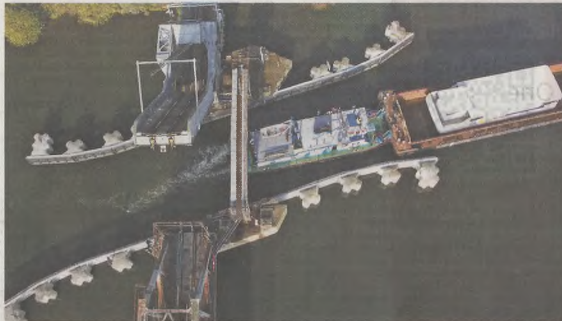
Most kolejowy w Podjuchach to wąskie gardło dla żeglugi śródlądowej.
