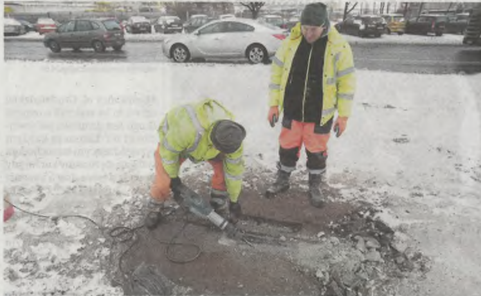
▶ Krótki atak zimy nie przeszkodził ekipom w sprawdzaniu i naprawie spawów. Jednak spawanie odbywa się przy pomocy łuku elektrycznego, a nie termitem, który wymaga temperatury 5 stopni C
