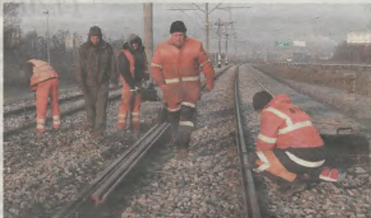
Brygady BTW Bahn Technik podczas styczniowej wymiany miejsca z wadliwym spawem na wysokości dąbskiego lotniska
