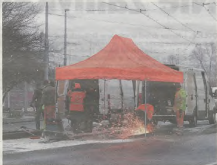
Czwartek, 14 stycznia. Robotnicy spółki Taumer w trakcie robót w rejonie mostu Portowego nad Parnicą.
