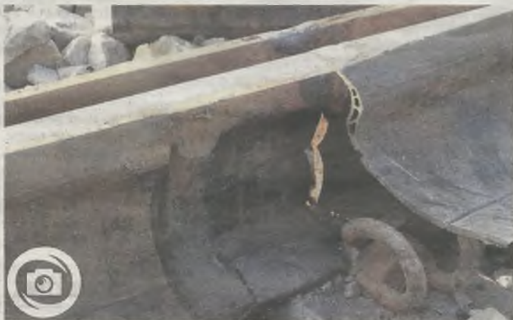
Jedno z miejsc pęknięć w torowisku na ul. Gdańskiej
